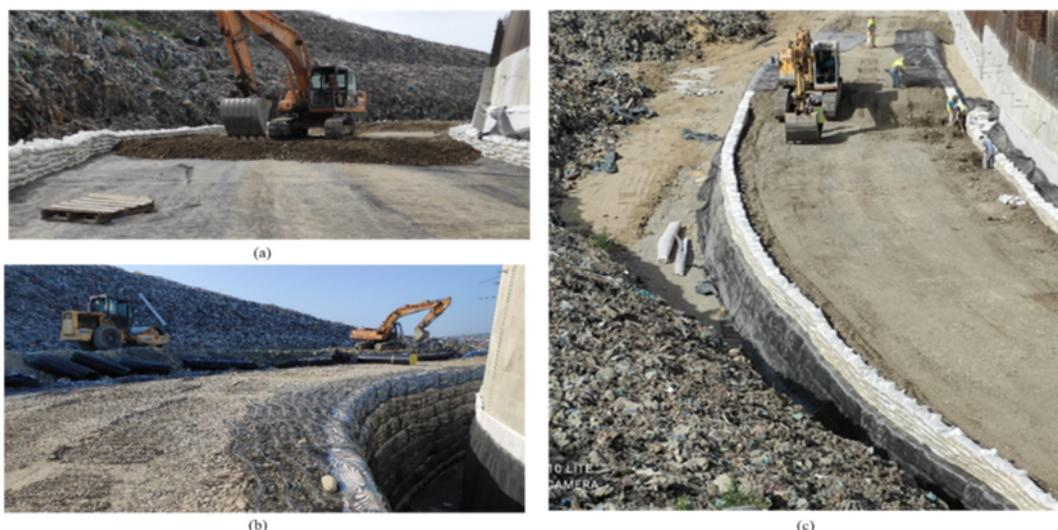
Figura 8. Fasi realizzative della terra rinforzata con geogriglie estruse 100% in HDPE: (a) Sand-bags posizionati sulle facciate anteriore e posteriore dell'argine in terra rinforzata e stesa del terreno di riempimento, (b) intercapedine fra il muro in calcestruzzo e la terra rinforzata finalizzata ad accogliere il materiale granulare non compattato al fine di assorbire le eventuali deformazioni; (c) Piste di cantiere e fasi di movimentazione e compattazione del terreno di riempimento.
