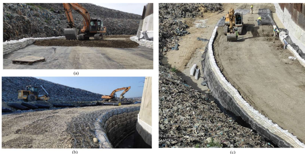
Figura 8. Fazat e ndertimit te tokes se perforcuar me zgarra te ekstruduara 100% HDPE: (a) Thase-rere te vendosur ne fasadat e perparme dhe te pasme te argjinatures se terrenit te perforcuar dhe dheu mbushes i vendosur, (b) zgaver (interkapedine) midis murit te betonit dhe terrenit te perforcuar per t'u mbushur me materialin granular jo te ngjeshur ne menyre qe te absorboje deformimet e mundshme; (c) Pista te te kantierit te ndertimit ne fazat e levizjes dhe ngjeshjes se terrenit me mbushje.
